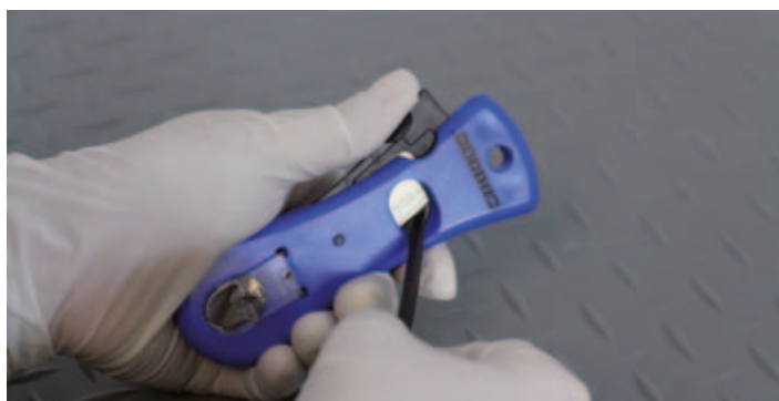
1 Отрежьте кусок уплотнительного материала
